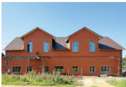
► Обследование строительных конструкций магазина в п. Михнево Ступинского муниципального района
