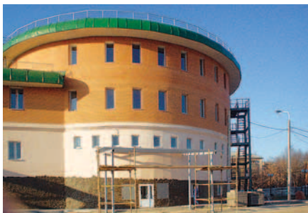
► Обследование строительных конструкций торгового центра в г. Домодедово
