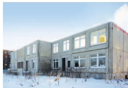
► Обследование строительных конструкций детского сада в п. Мещерское Чеховского муниципального района
